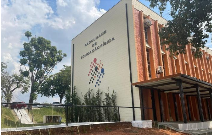
Imagem 1: Edificação Faculdade de Educação Física - 2025. Autor: Edivaldo Góis; Glaurea Oliveira
